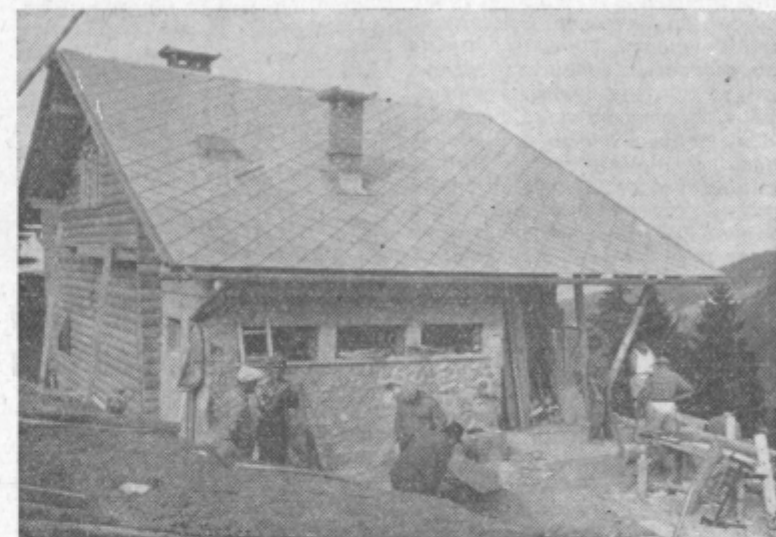
Dom na Vrheh med gradnjo
