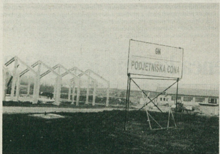
PODJETNIŠKA CONA V KOČEVJU - Ob cesti med Kočevjem in Bregom nastaja podjetniška cona, ki jo nekateri imenujejo tudi obrtniška cona. Dograjena je že mizarska delavnica, zdaj pa sta v gradnji še dve prostornejši in višji hali, ki bosta last več obrtnikov. V obeh bodo organizirali proizvodnjo, trgovino ali pa še kaj drugega. Nekateri politične stranke pa že menijo, da je v Kočevju dovolj takih poslovnih prostorov, ker je nekaj večjih podjetij propadlo, in da so take gradnje nepotrebne, kar so zapisale tudi v svoje volilne programe. (Foto: J. Primc)
