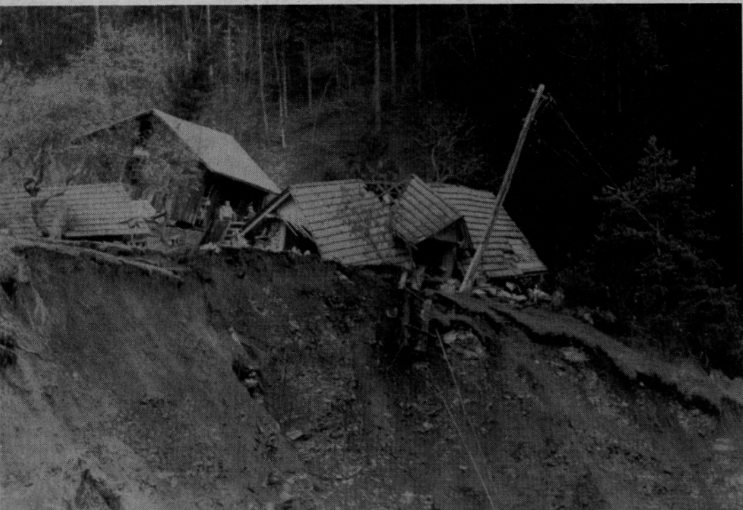
Plaz je uničil stavbe pri Pečovnikovih v Podvolovljeku
