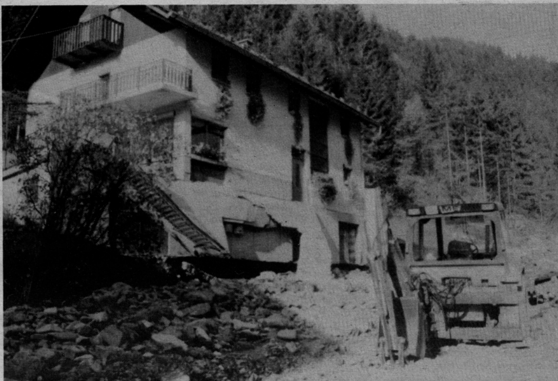
Poškodbe na hišah na Ljubnem
