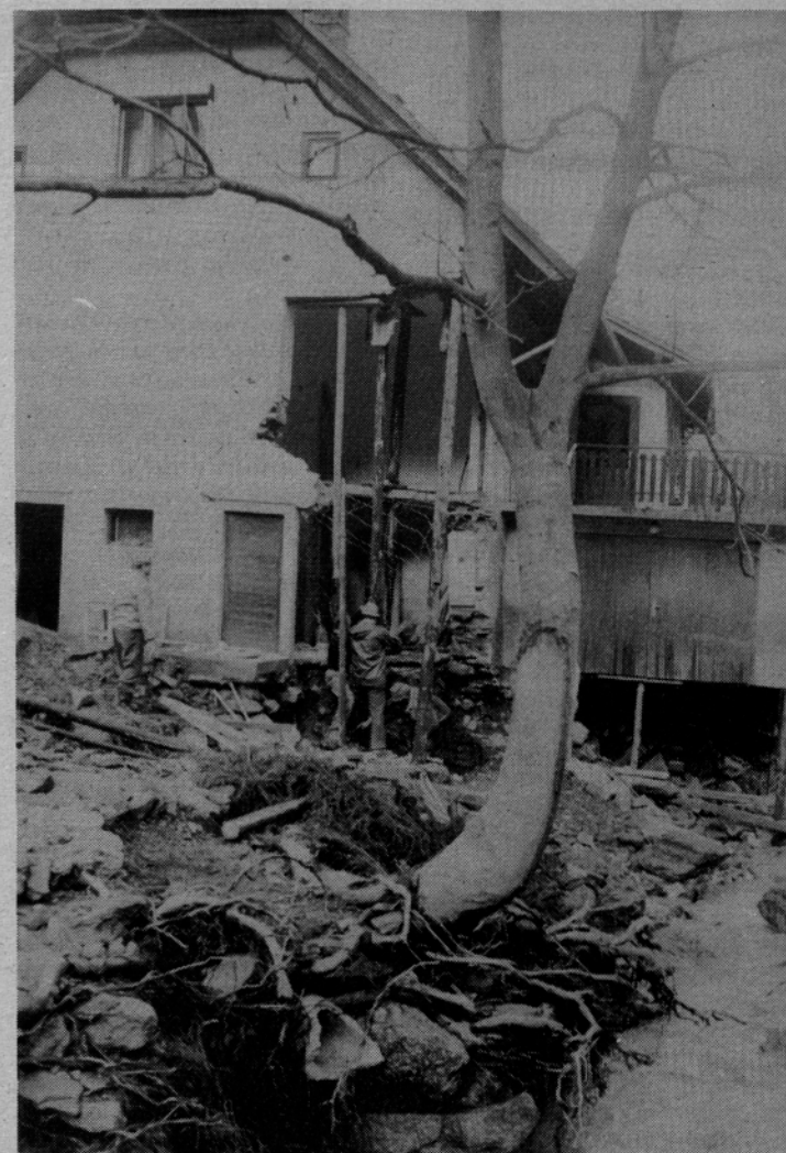
Pri Lipoldovih v Trbižu so podprli hišo, da se ni zrušila
