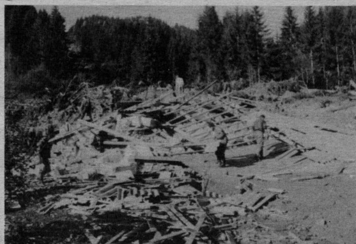
Pred Lučami je plaz uničil lepo stanovanjsko zgradbo
