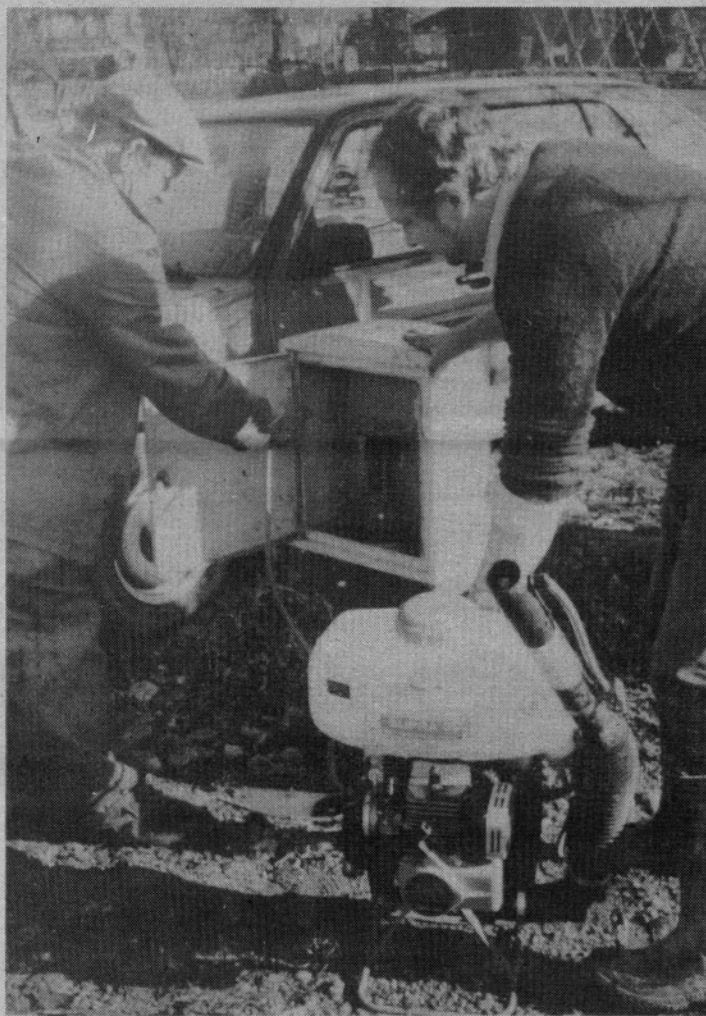
Takole so izpirali delavci PTT omarice
