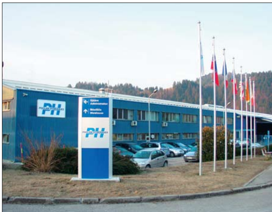
Poslovna stavba Poclain Hydraulics v Žireh
