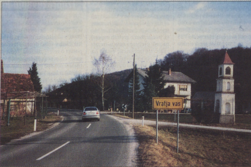
Skozi Vratjo vas (na sliki) in še deset kilometrov naprej po Apaški dolini pelje dokaj lepa cesta. Skozi Črnce, Apače in Segovce pa je asfalt izjemno uničen. Foto: F. Š.
