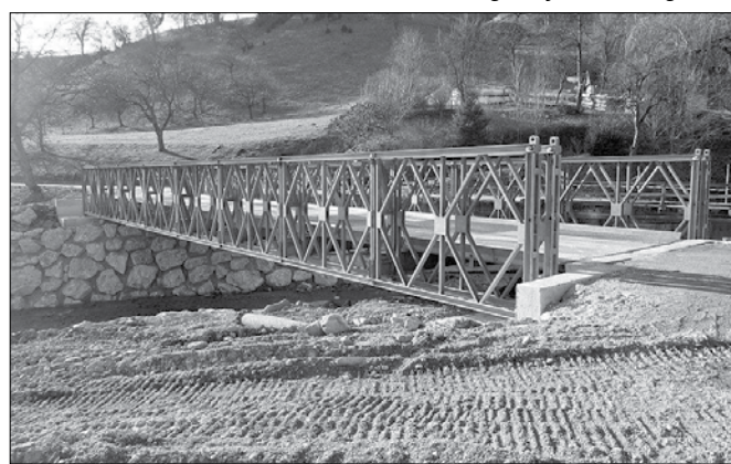
Namesto Pažetovega mostu, s sanacijo katerega v občini Ljubno pričenjajo v teh dneh, je bil za prehod preko reke postavljen montažni most. (Fotodokumentacija Občine Ljubno)
