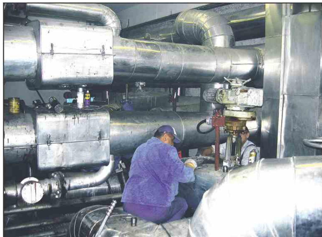
V centralni energetske postaji so obnovili visoko in nizko napetostne elektro energetske naprave, transformatorje, elektromotorje črpalnih agregatov, elektro zažigalnike, ...
