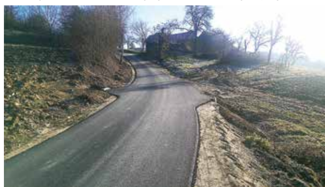
Rekonstrukcija ceste Beli križ - Kuftovi (foto: arhiv občine)
