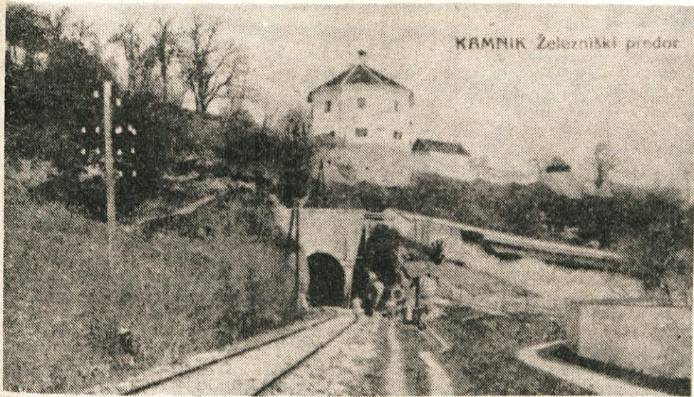
750 let Kamnika – pogled na železniški predor pred več desetletji.
