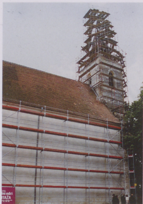
Obnova tišinskega zvonika
