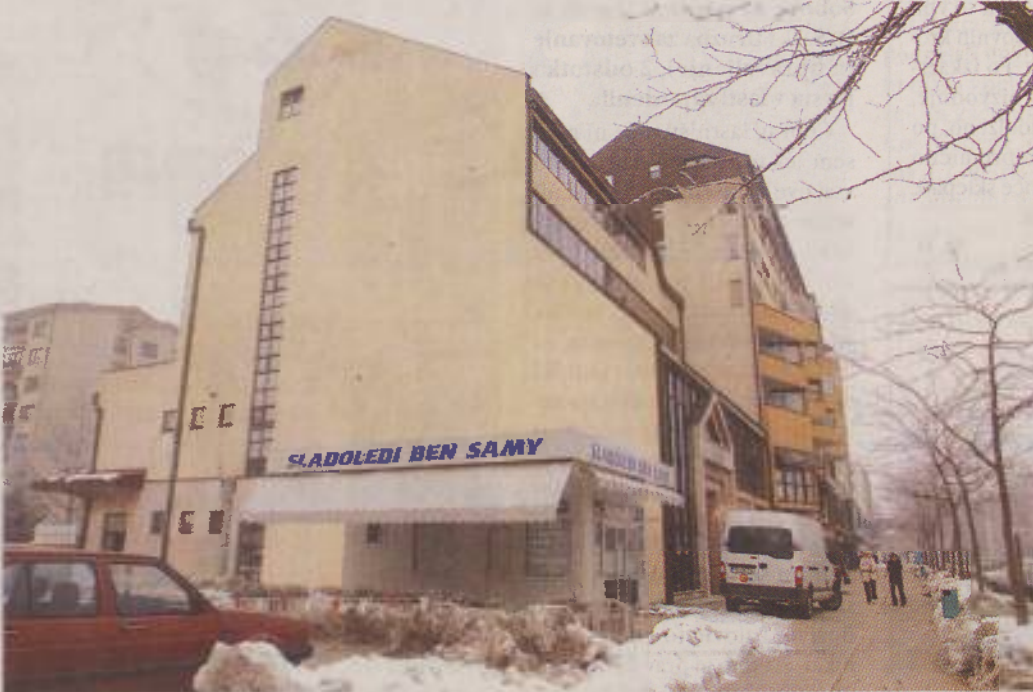
Ta čas del nekdanje Panonke v Kocljevi ulici že urejajo za potrebe bančne poslovalnice, kmalu pa naj bi tik ob njej začeli graditi upravni center in prvo mestno garažno hišo.
