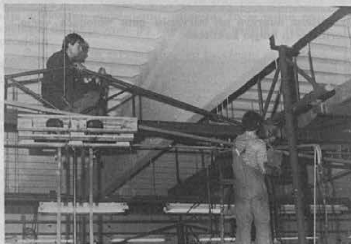
V orodjarni so med dopustom montirali nosilce »glajze« za dvigala
