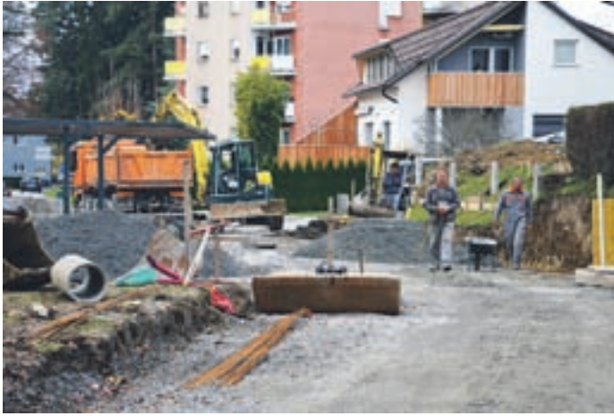
Dela na Šlandrovi cesti so bila temeljita, zavlekla pa so se tudi zaradi izgradnje opornega zidu ob njej. Potreba, da ga postavijo, se je pokazala sredi del.
