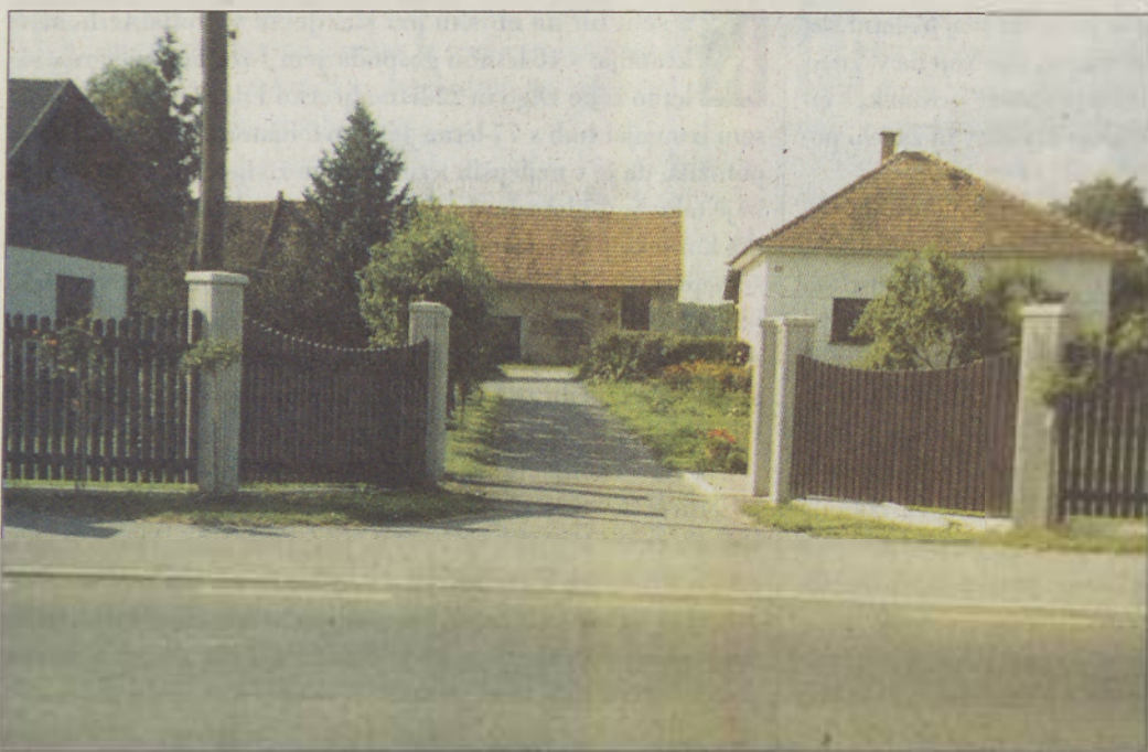
Idejo za Pevčevo ograjo je naredil arhitekt Andrej Stržisar.
