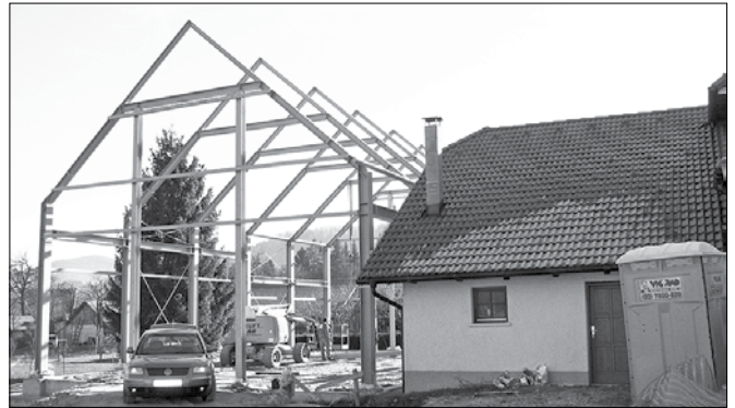
Konstrukcija za novi gasilski dom v Radmirju (Foto: Marija Lebar)
