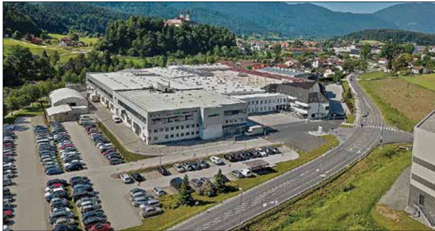
Na strehi tovarne naj bi do poletja postavili sončno elektrarno z inštalirano močjo enega megavata. (Foto: arhiv podjetja BSH)
