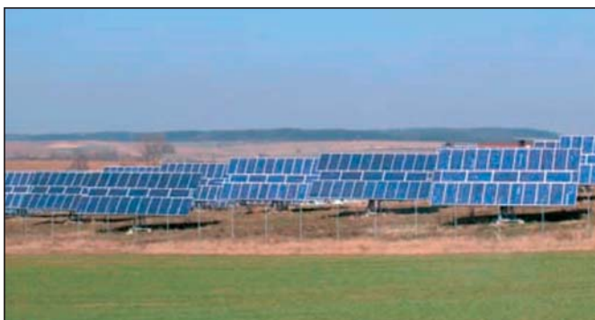
Sončna elektrarna z dvoosnim sledenjem soncu
