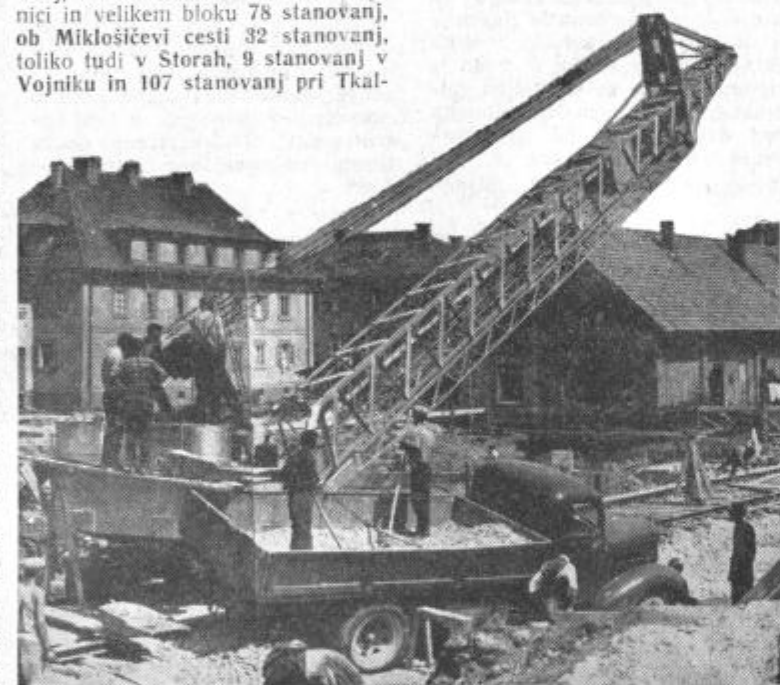
Žerjav na gradbišču »107« (toliko bo stanovanj v enem stolpiču).
