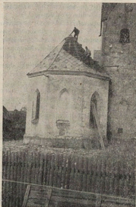
Tesarska dela na dvorski cerkvi
