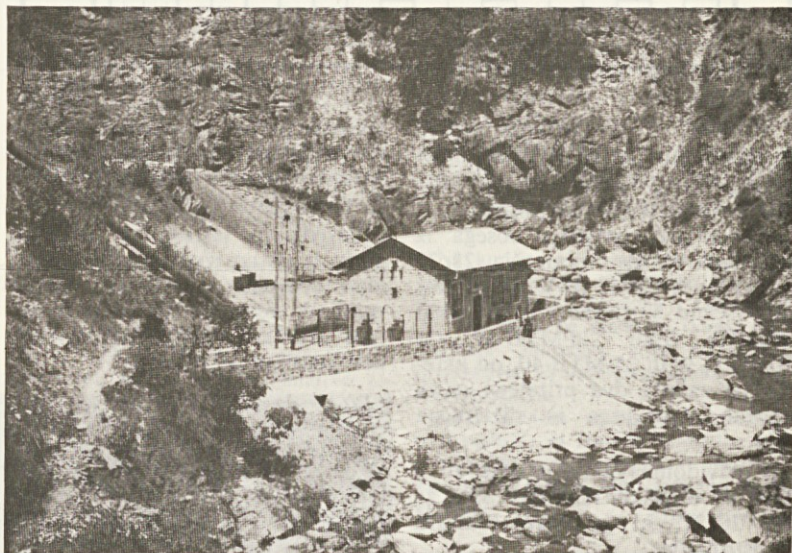
Strojnica z delom tlačnega cevododa v kanjonu reke Salyani v Nepal. Tu sta montirana dva agregata, moč vsakega pa je po 100 kW
