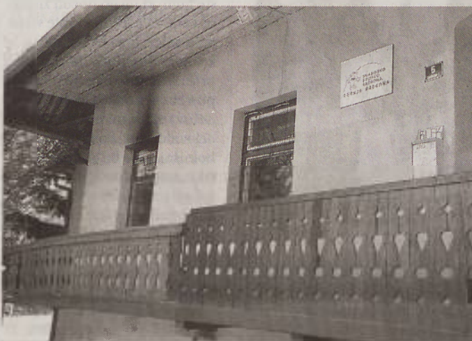
Med najbolj priljubljenimi je bil norički vrtec, ki so ga zaprli 1992. leta; od takrat ta občinska stavba nezadržno propada, kar je velika škoda.
