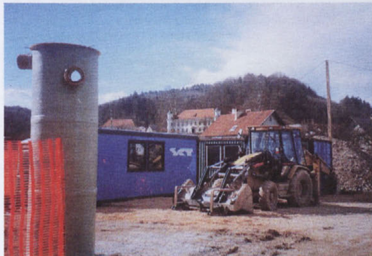
Začela se je že lani napovedana izgradnja kanalizacije Vaše - Goričane.
