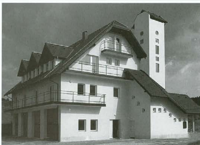
Gasilski dom: tako mogočno se bohoti nov gasilski dom ob vstopu v Kotlje. Avtor: Tomo Jeseničnik
