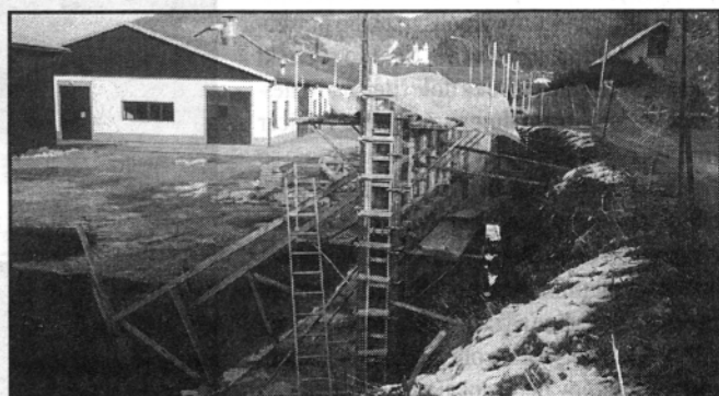
Gradnja opornega zidu intenzivno poteka (foto: M. Šukalo)
