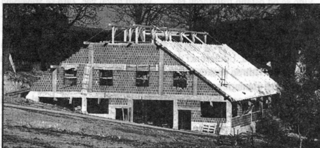
Nov gospodarski objekt Atelškovih je še pred prvim snegom dobil streho (foto: Jože Miklavc)
