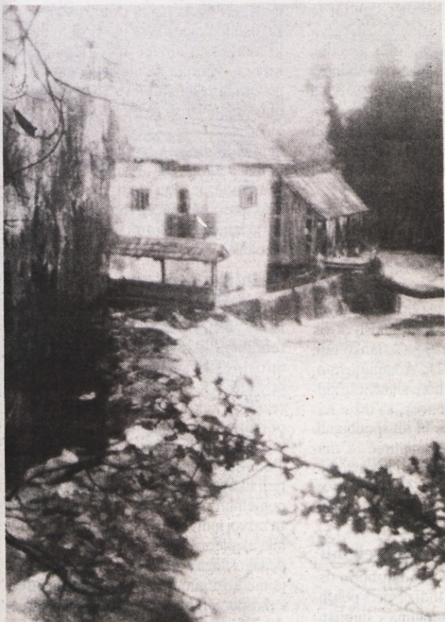
Slika mlina in žage v Marinči vasi št. 13 danes in slika istega mlina z vrisanim možnim celotnim objektom mHE, kjer je bruto padec 3.4 m pri skupnem srednjem letnem pretoku 11 m 3 /s
