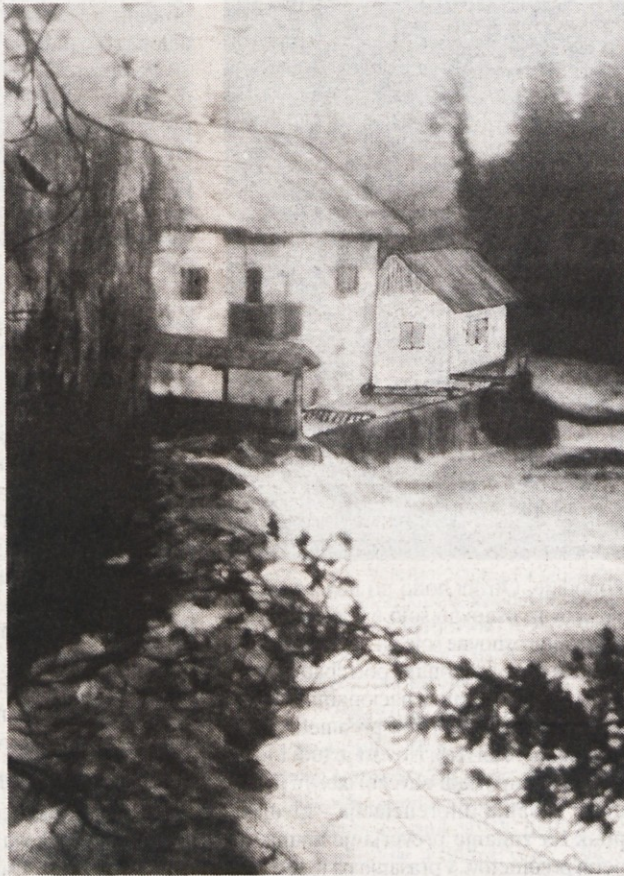
Slika mlina in žage v Marinči vasi št. 13 danes in slika istega mlina z vrisanim možnim celotnim objektom mHE, kjer je bruto padec 3.4 m pri skupnem srednjem letnem pretoku 11 m 3 /s
