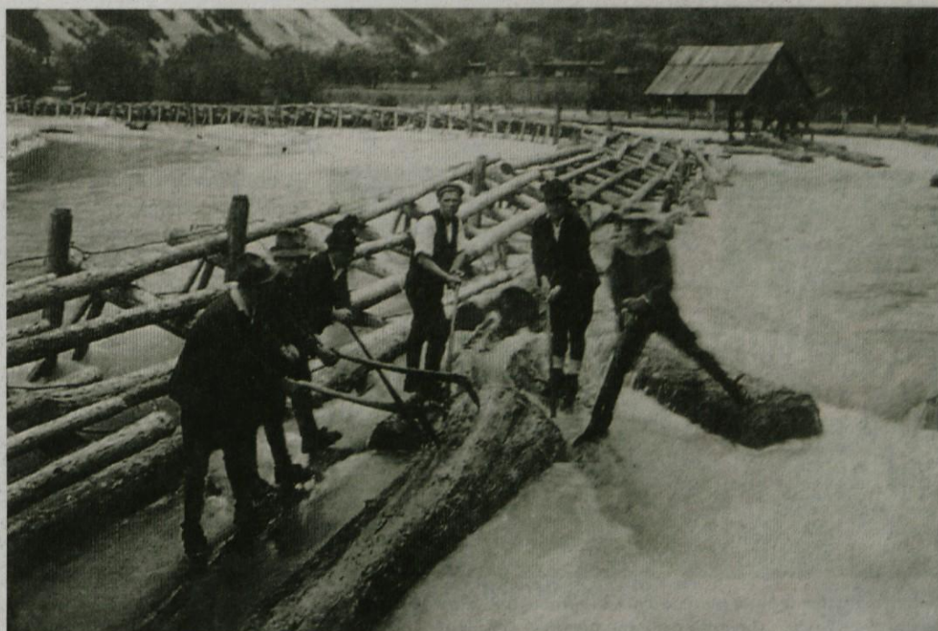
Plavci usmerjajo hlode po kanalu Kamniške Bistrice do žage v Stahovici. Grablje – ograja iz lesa – pa preprečujejo, da bi voda odnesla les naprej po Bistrici.
