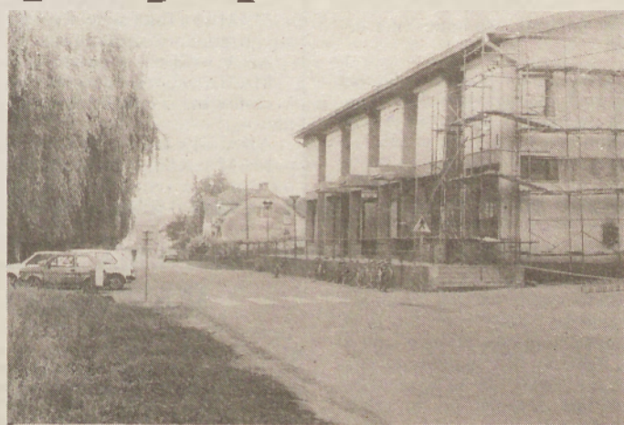
OBNAVLJANJE VAŠKO-GASILSKEGA DOMA — Ob bližnji otvoritvi novega šolskega poslopja si je »načela novo obleko« tudi osrednja zgradba v središču Bakovec. Foto: M. Jerše.
