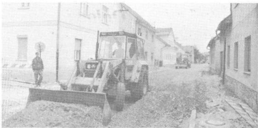
Cesta IV bo kmalu dobila asfaltno prevleko
