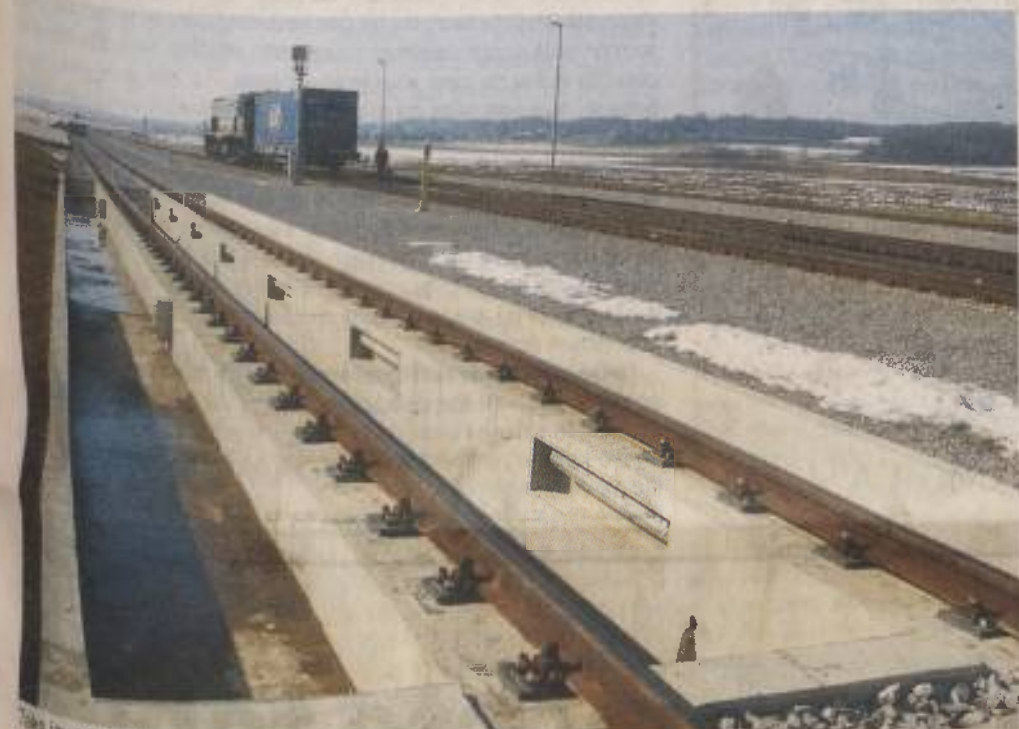
Tako imenovani kanal na železniškem mejnem prehodu Hodoš, na katerem pregledajo podvoze vlaka. Notranjost in podvoze vlaka so temeljito pregledali pripadniki posebne enote za protibombno zaščito iz Maribora in soboški kriminalisti. Pri pregledu so sodelovali tudi vodniki s službenimi psi, naučenimi, da odkrivajo eksplozivna sredstva.
