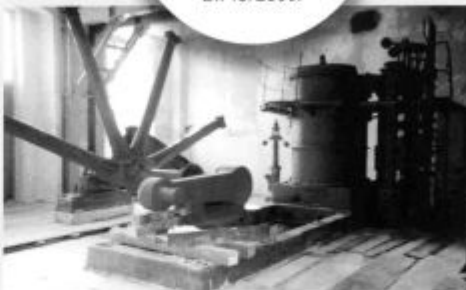
Pogonski parni stroj črpalke Kley po prvi fazi montaže na prvot- nem mestu v stavbi jaška Franciške, 27. 10. 2003.
