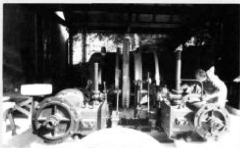
Restavratorska dela na izvoznem stroju s pamim pogonom tovarne Breitfeld, Daněk&Co.Prag iz leta 1890, 9. 7. 2002.
