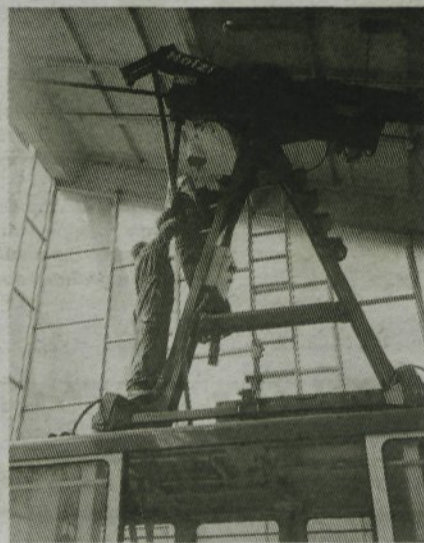
Žičničarji pri obnavljanju mehanizma na nihalki.
