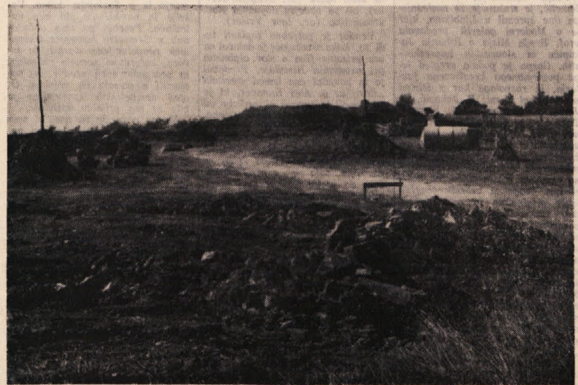
Pogled na gradbišče na Katinari
