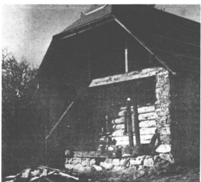
Domačija po obnovi strehe in severnega zidu
