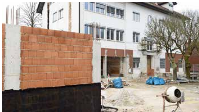
Obnova občinske stavbe je v polnem teku. Želijo si, da bi se občinska uprava vanjo vrnila v številnejši zasedbi. / Foto: Peter Košenina
