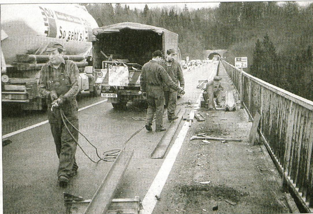
Letos bo med poletnimi meseci na glavnih slovenskih cestah manj gradbišč.
