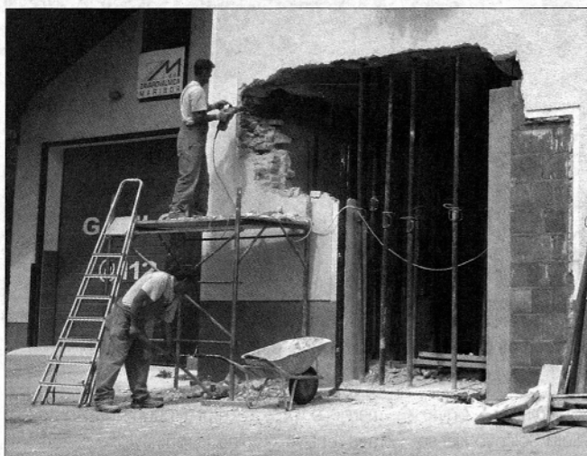
Dela na adaptaciji garaže v Šmartnem ob Dreti (foto: Marija Lebar)
