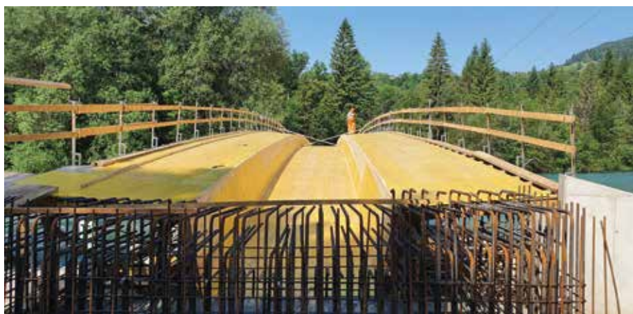
Gradnja mostu na Piškovci
