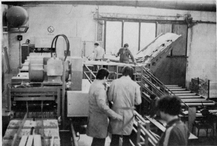
Montaža stroja Optimes za širinski razrez
