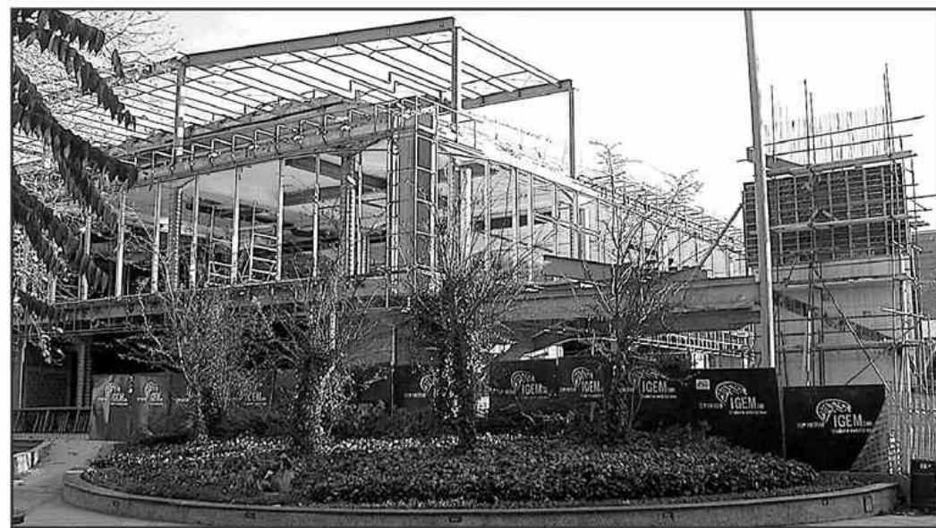
Obnova nekdanje Name ne napreduje tako hitro, kot so računali investitorji. Predvsem zato, ker so morali zamenjati veliko več, kot so računali pred začetkom obnove.
