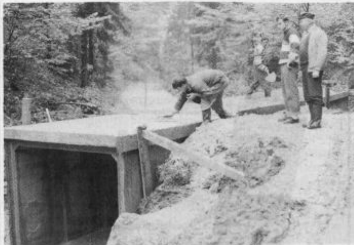
Dela pri obnovi mostov, ki jih je poškodovalo predlansko neurje, po mnenju Viktorja Potočnika, potekajo prepočasno. Denar za naložbo je prispevala republika
