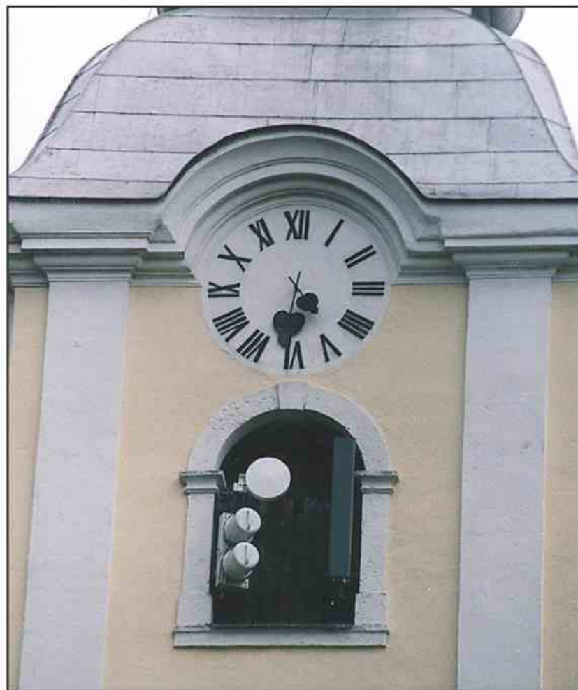
Večina antenskih baznih postaj je postavljena v zvonikih cerkva in turnih gasilskih domov. Ena prvih je antena v Velenju dobila Šmarška cerkev in to na črno.
