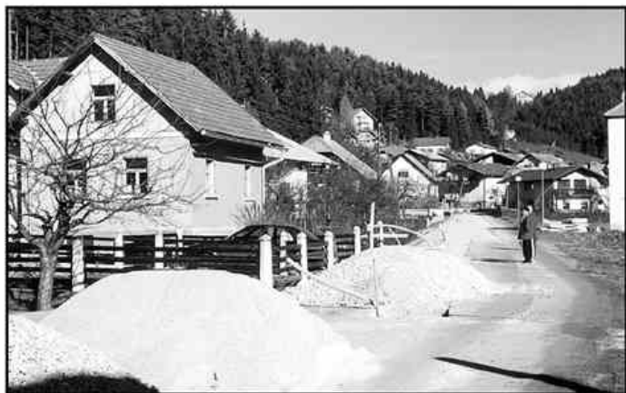
Hkrati gradijo omrežje KRS in kanalizacijsko omrežje.
