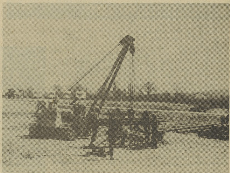
Krivljenje cevi na deponiji
