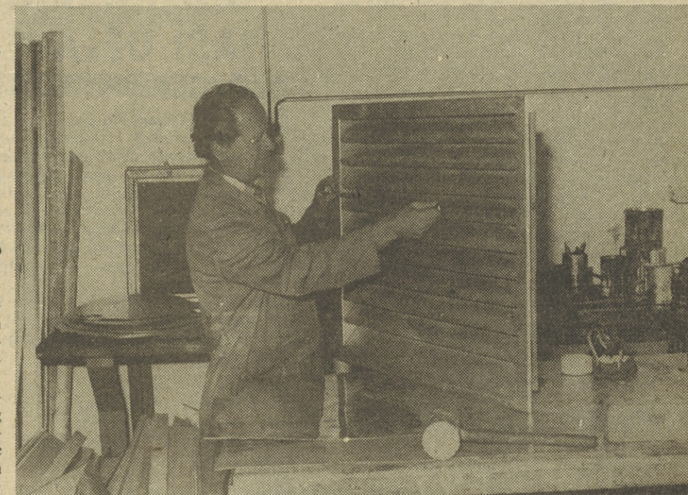
Izdelava žaluzij v kleparski delavnici
