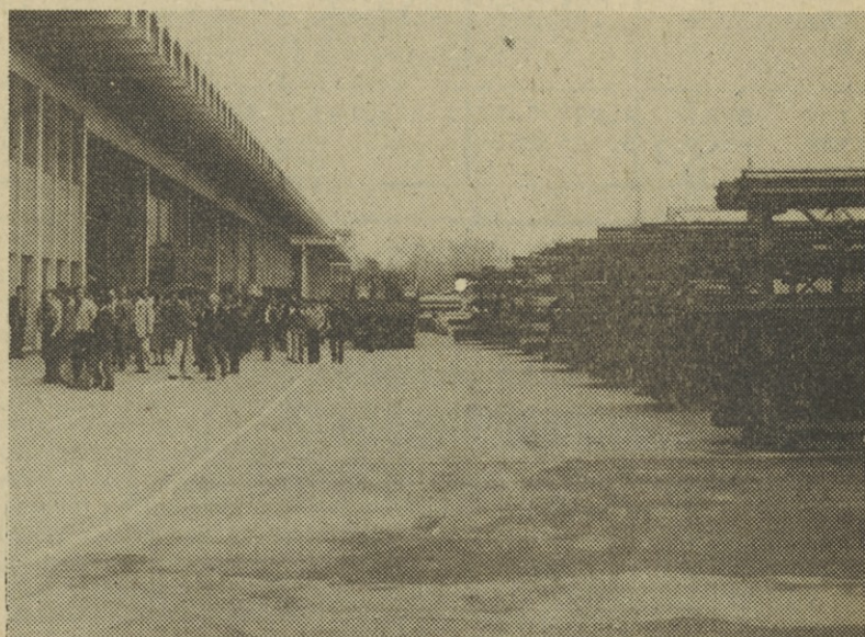
Zunanji del skladišča
