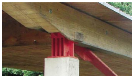
Slika 7 • Naleganje nosilca GL36c na jekleno podporo
