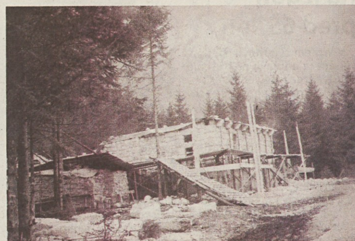
Lovska kočja med gradnjo aprila 1933 (foto Peter Naglič iz Šmarce)
