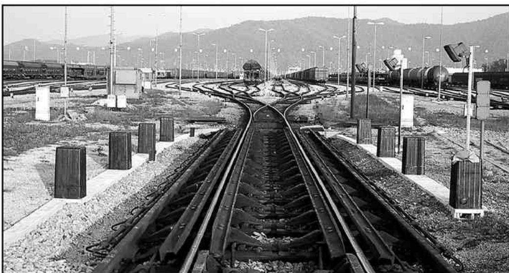
Takole izgleda nagrajena inovacija, ki je moč hrupa na tirnih zavorah na ranžirnem kolodvoru železnic zmanjšala za 99,9%.
