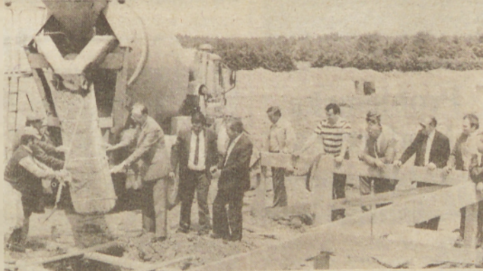
NOVI HLEVI — Na ekonomski enoti Ginjevec pri Nedelici bodo do 15. septembra zgradili tri hleve s po 200 stojišči. Na sliki: Slovesen začetek gradbenih del. Foto: Š. S.
