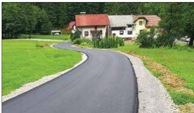
V Zgornjem Dolu je bila z asfaltiranjem zaključena rekonstrukcija 600-metrskega odseka ceste. (Foto: arhiv Občine Gornji Grad)
