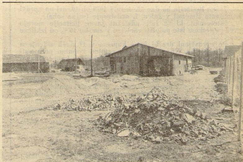
TOZD Gradbeništvo gradi poleg betonarne v Vrbju še žago in urejuje okolico
