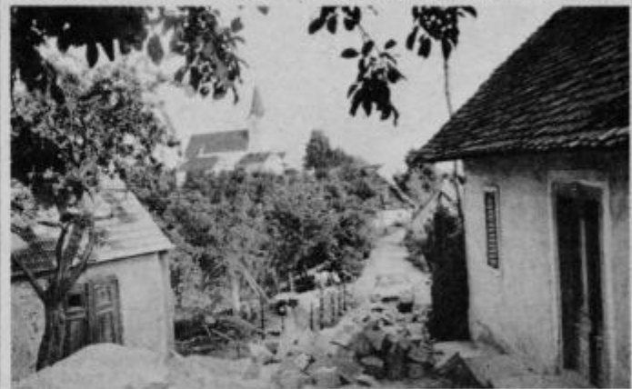
Gradnja škarpe na novem odseku ceste Prihova—Straža.
