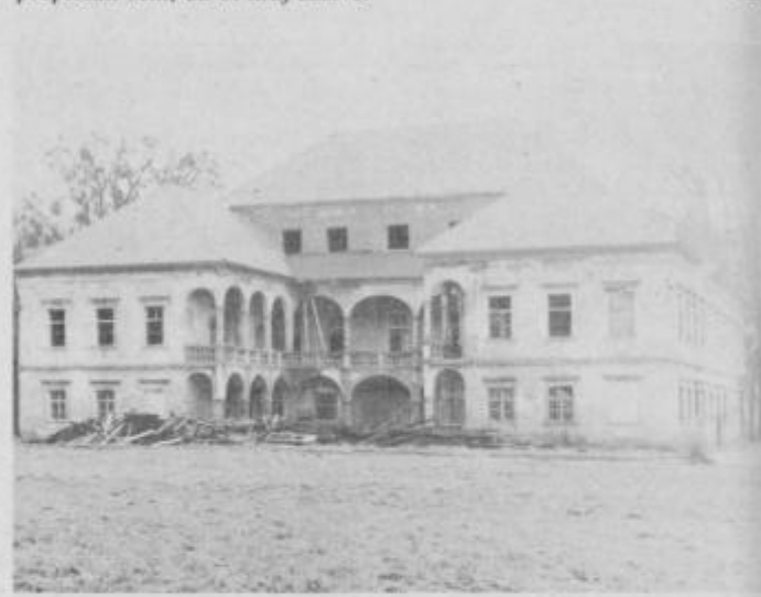
Graščina po delni obnovitvi
