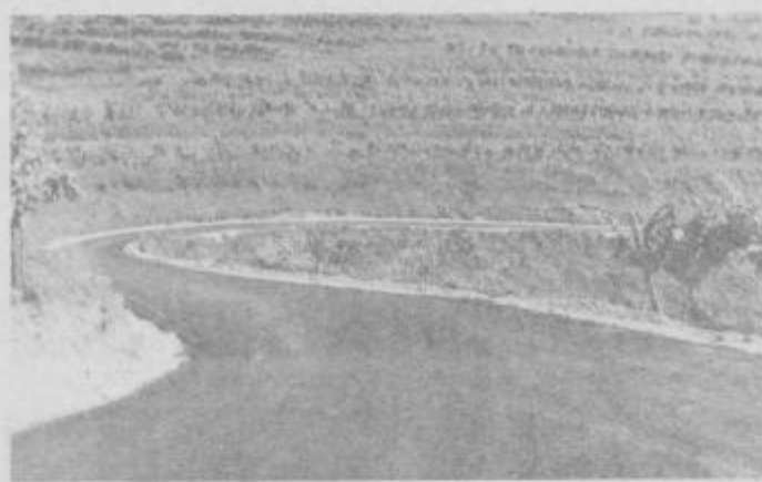
Sad tretjega občinskega samoprispevka — asfalt v Majski in Dravinski vrhi.
